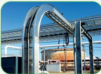
Échelles à câbles I-BEAM et accessoires de raccordement
